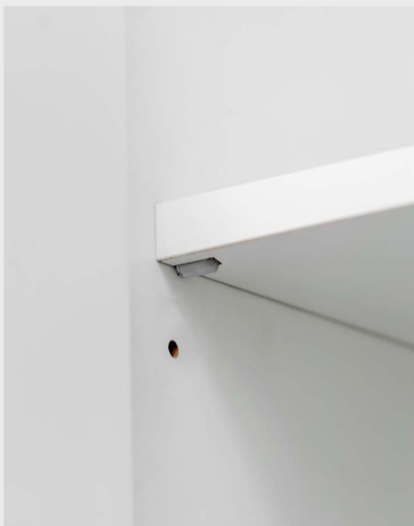
Półki w szafkach wiszących zabezpieczone przed wysunięciem.
